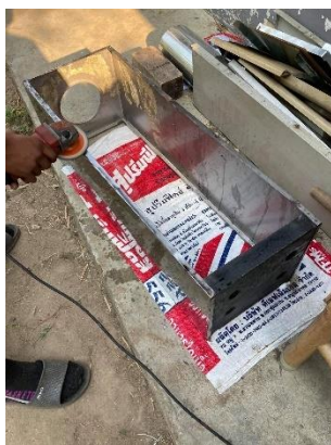
ภาพที่ 3.1 นำโครงตู้กักน้ำมาทำความสะอาดให้เรียบร้อย
