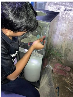
ภาพที่ 3.4 ติดตั้งก๊อกน้ำและต่อวงจรเซ็นเซอร์ให้เรียบร้อย
