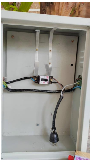
ภาพที่ 19 ขั้นตอนการทำงาน ชั้น 3
