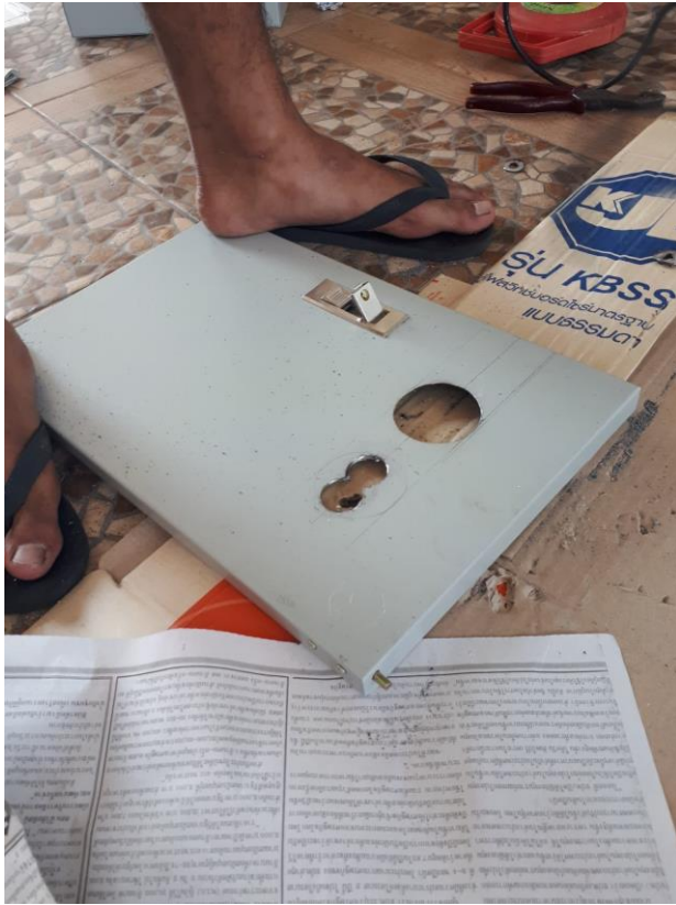
ภาพที่ 7 ขั้นตอนการทำงาน ชั้น 2
