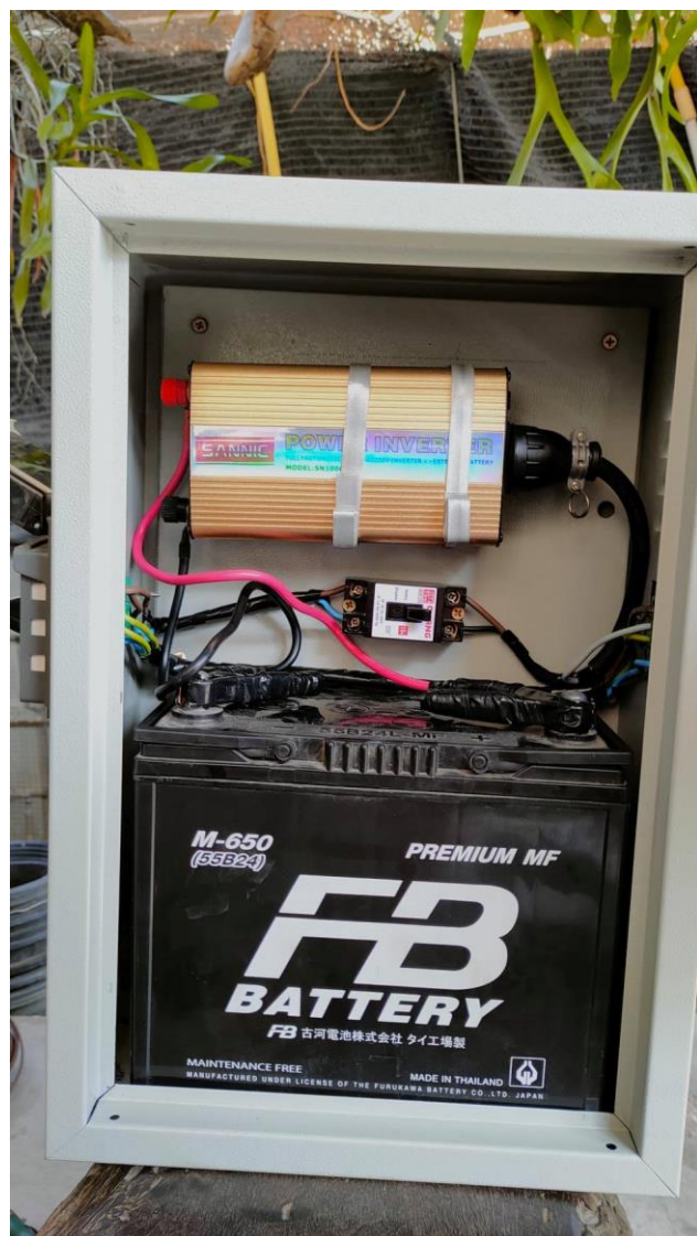
ภาพที่ 20 ขั้นตอนการทำงาน ชั้น 3
