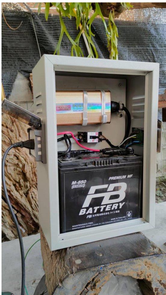
ภาพที่ 19 ขั้นตอนการทำงาน ชั้น 3
