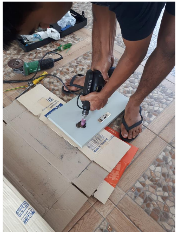
ภาพที่ 6 ขั้นตอนการทำงาน ชั้น 2
