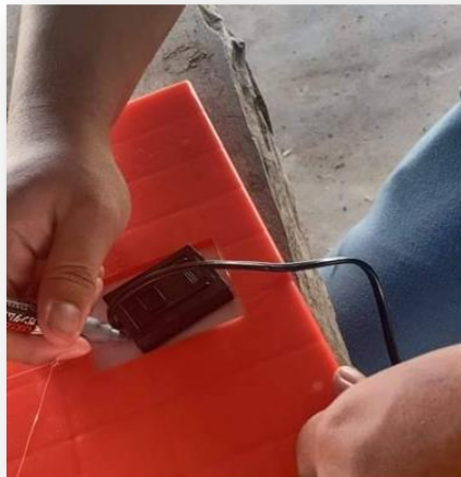
รูปที่ 28 ติดตั้งสายไฟ
