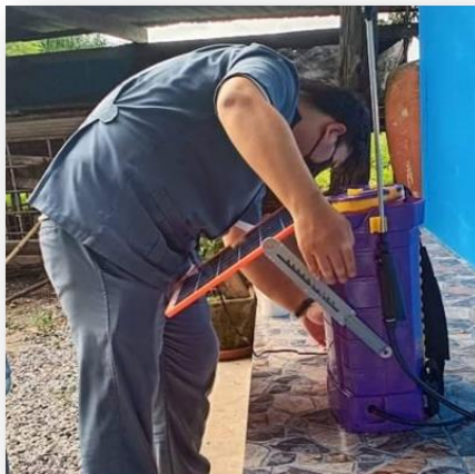
รูปที่ 29 ติดตั้งแผงโซล่าเซลล์
