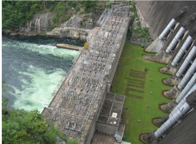
รูปที่ 3.12 แสดงโรงไฟฟ้าพลังงานน้ำจากเขื่อน ที่มา : https://powerplant2.files.wordpress.com
