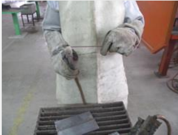
รูปที่ 1.4 แสดงการเปลี่ยนลวดเชื่อม ด้วยความระมัดระวัง
