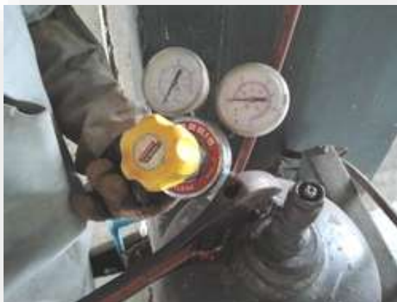
รูปที่ 2.56 แสดงการติดตั้งอุปกรณ์ปรับความดันแก๊สอะเซทิลีน
