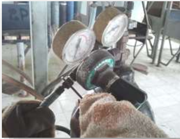
รูปที่ 2.42แสดงต่อสายเชื่อมเข้ากับอุปกรณ์ปรับความดันแก๊สออกซิเจน
