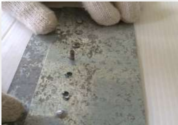
รูปที่ 3.152 แสดงการตัดหมุดย้ำที่ยาวเกินไป
