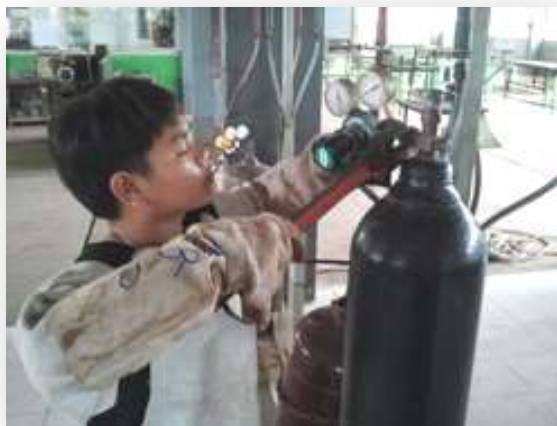
รูปที่ 2.54แสดงการติดตั้งอุปกรณ์ปรับความดันแก๊สออกซิเจน
