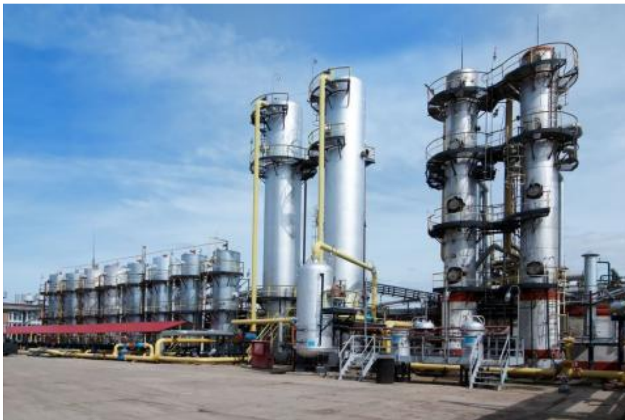
ภาพที่ 7.15 แก๊สโซลีนได้จากกระบวนการแยกแก๊สธรรมชาติ ที่มา http://www.bicmagazine.com/expansions/downstream-subsection/epa-permit-gas-to-gasoline-plant-nederland-texas/
