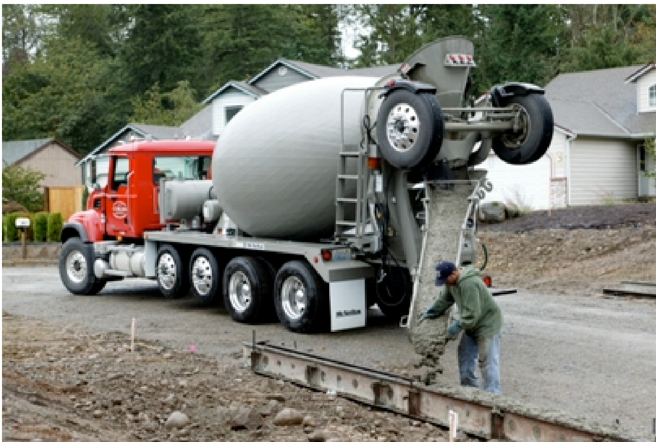
ภาพที่ 9.23 คอนกรีตผสมเสร็จ
