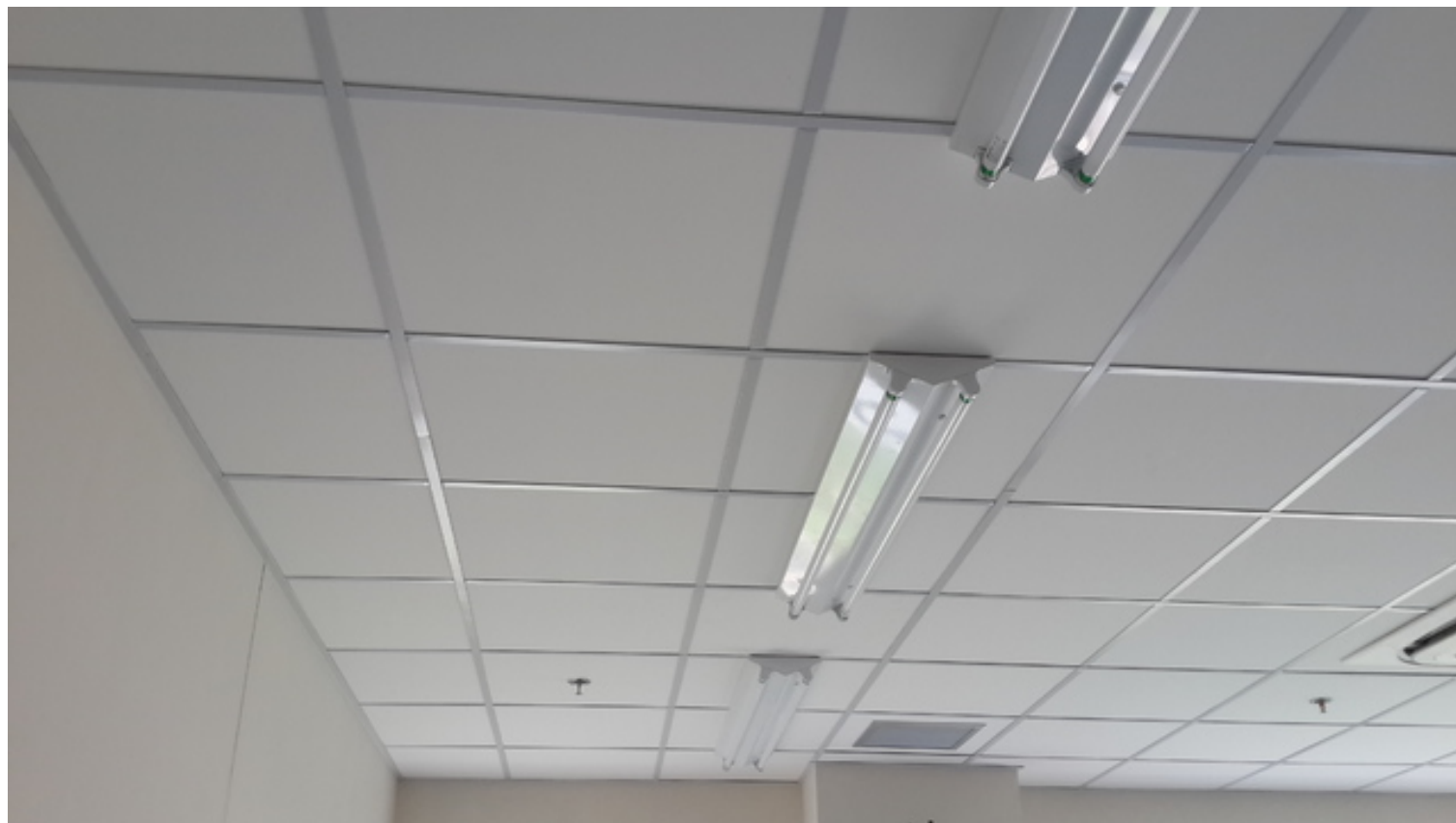
ภาพที่ 9.11 กระเบื้องแผ่นเรียบสำหรับฝ้าผนังและฝ้าเพดาน ที่มา http://forum.khonkaenlink.info/index.php?board=47.1800
