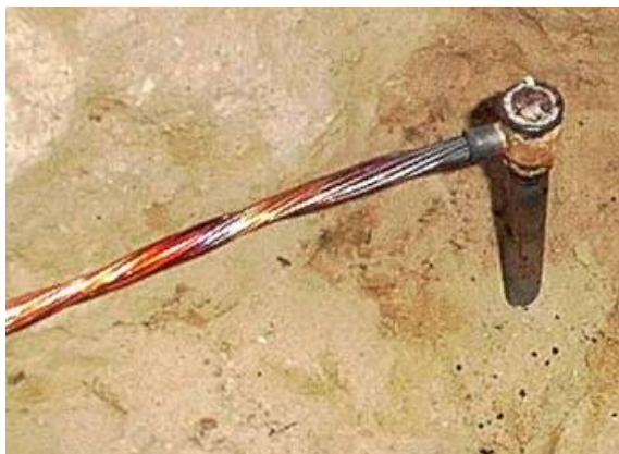
รูปที่ 7.14 แสดงการติดตั้งด้วยเบ้าหลอมหลักดิน ที่มา : https://www.bloggang.com
