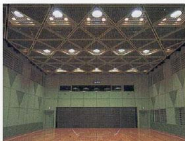
รูปที่ 15.4 แสดงการติดตั้งหลอดไฟในตำแหน่งที่มิให้เกิดแสงแยงตา
