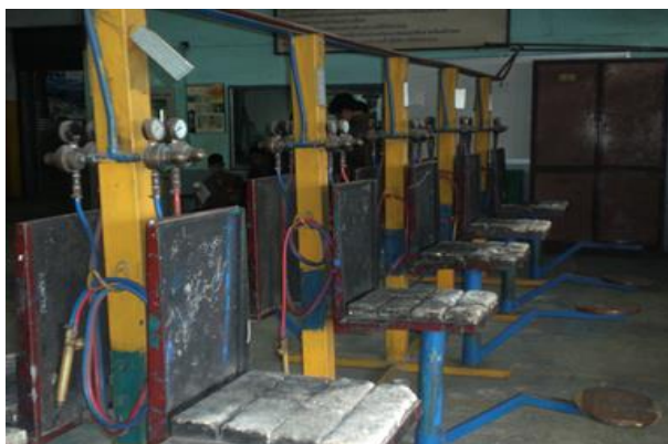
รูปที่ 4.2 แสดงบริเวณพื้นที่ปฏิบัติงานเชื่อมแก๊สที่มีอากาศถ่ายเทได้สะดวก
