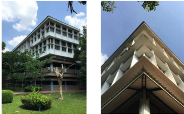
ภาพที่ 10 ตัวอย่างการออกแบบแผงกันแดด ยื่นชายคา และยื่นพื้นชั้นบนเพื่อบังแดดให้กับชั้นล่าง ที่อาคารเอนกประสงค์ มหาวิทยาลัยอุบลราชธานี
