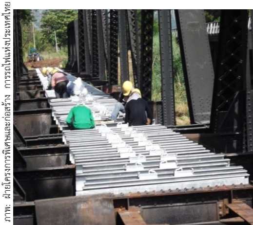
รูปที่ 7-9 การเปลี่ยนหมอนและติดตั้งรางกันบนสะพานเหล็ก
