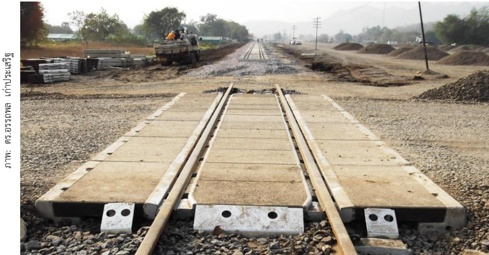
รูปที่ 7-16 แผ่นปูทางผ่านเสมอระดับชนิดคอนกรีตกำลังสูงสำเร็จรูป
