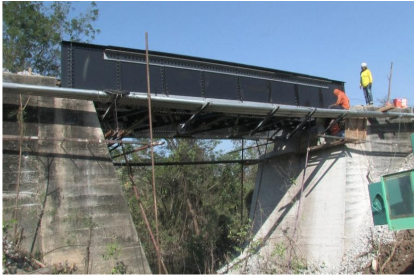
รูปที่ 7-10 การยกระดับสะพาน
