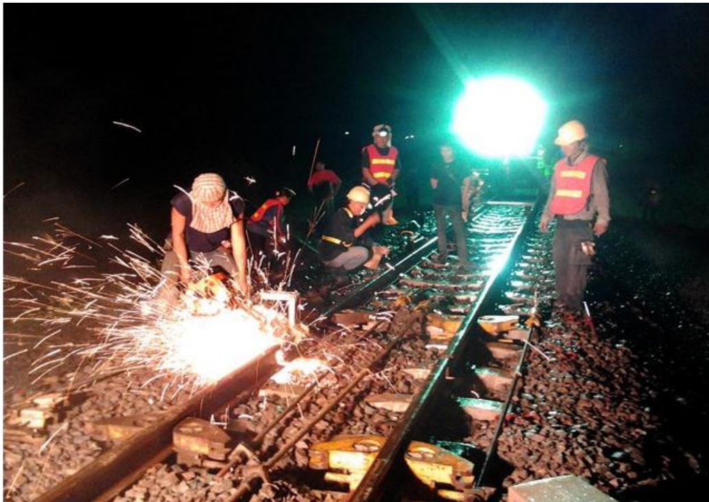
รูปที่ 7-13 การตัดรางเชื่อมยาวในทางเพื่อคลายความเค้น
