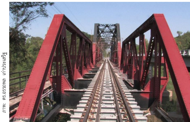
รูปที่ 7-20 การพ่นทราย (Sand Blast) และทาสีสะพานเหล็ก
