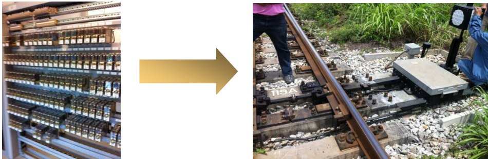
รูปที่ 9-8 รีเลย์สั่งการไปยังประแจกลไฟฟ้าที่อยู่ภายนอกผ่านสายเคเบิล
