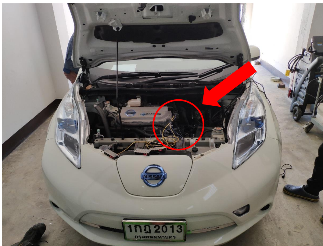
รูป 3-54 ตำแหน่งการติดตั้งเซ็นเซอร์วัดค่าพลังงาน
