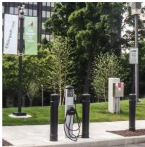
รูปที่ 51 ภาพการติดตั้งเสาป้องกันการกระแทกบริเวณสถานีประจุไฟฟ้า [30]
