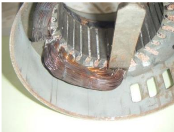
รูปที่ 2.4 การใช้สิ่วสกัดขดลวดมอเตอร์
