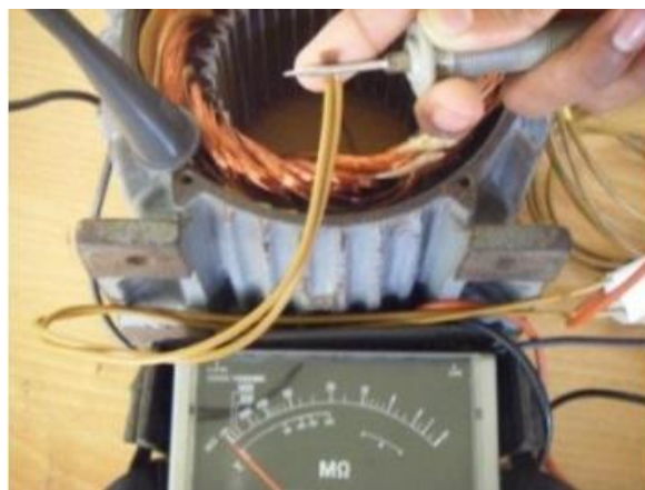
รูปที่13.5 ใช้แมกเกอร์ตรวจสอบการกราวด์มอเตอร์
