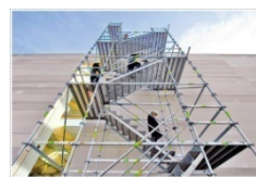
รูปที่ 1.1.10.2.3 การตรวจสอบสภาพนั่งร้านและบันไดขึ้นลงเพื่อให้ อยู่ในสภาพปลอดภัยพร้อมใช้งานในที่สูง
