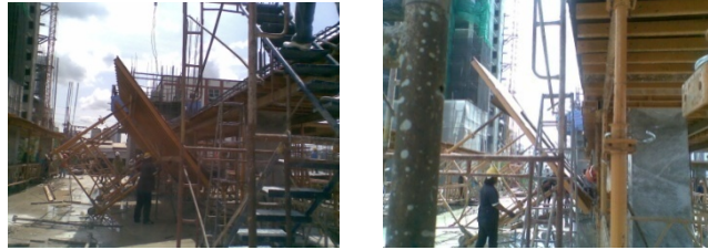
รูปที่ 1.1.10 การวางวัสดุด้านเดียวทำให้โต๊ะนั่งร้านกระดก
