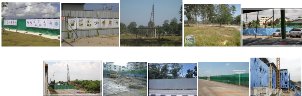
รูปที่ 1.1.10.2.1 การล้อมรั้วกันบริเวณเขตก่อสร้าง
